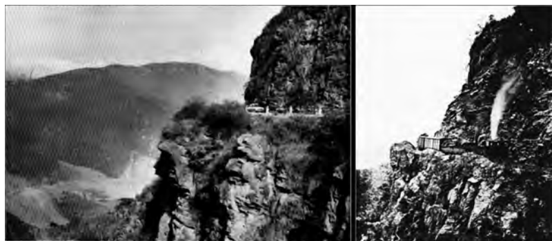
FIGURA 3 : PASO DE LA CARRETERA Y DEL FERROCARRIL POR LA “PEÑA DE MORA”
