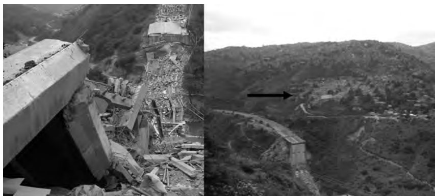
FIGURA 6 : EL VIADUCTO CAIDO
